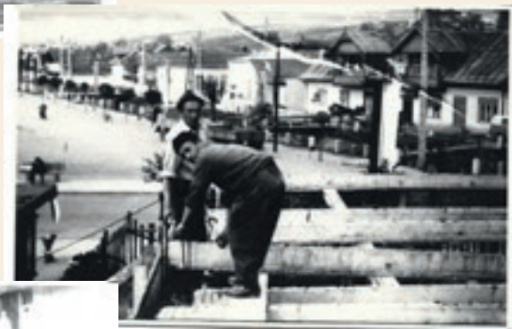
Na budowie nowej siedziby Banku przy Rynku w Łącku, rok 1967. FOT. ARCH.
